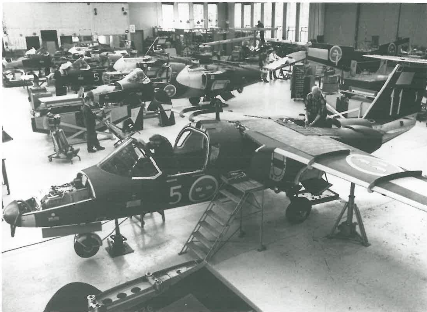
Ombyggnaden av SK 60 till lätt attack genomfördes vid FFV Aerotechs verkstäder i Linköping
